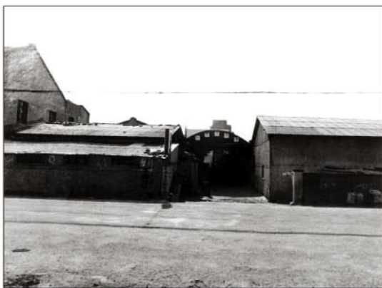
早期的廠房外觀二景
